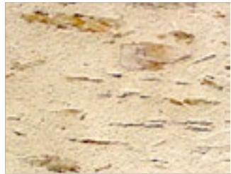
Enduit A pierre vue
