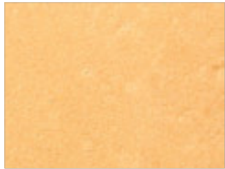
Enduit Aspect lissé
