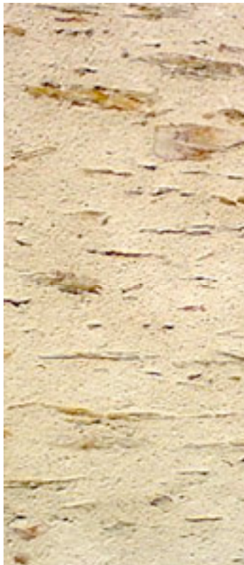
Enduit A pierre vue
