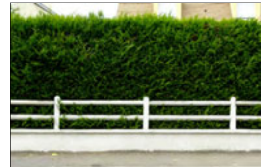
Clôture: Haie et lisses sur muret
