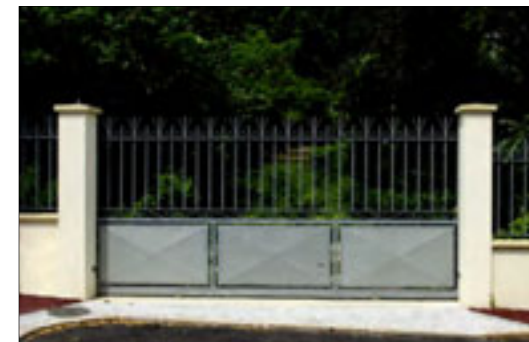
Portail droit à piliers maçonnes enduits
