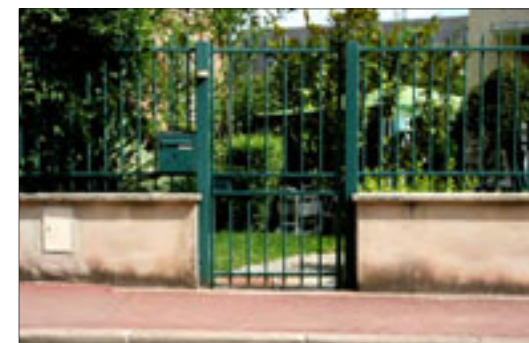
Portillon droit à poteaux métalliques.
