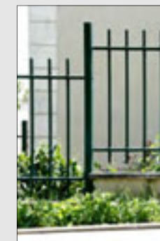
Travée à barreaudage
