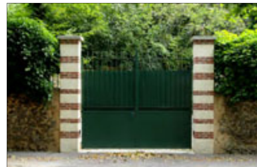
Portail droit à piliers maçonnes (Brique et enduit ton pierre)
