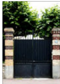
Portail galbé à piliers maçonnes (brique et pierre)
