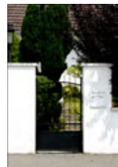
Portillon galbé à piliers maçonnes enduits
