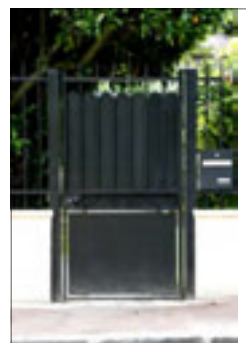
Portillon droit à décors et poteaux métalliques
