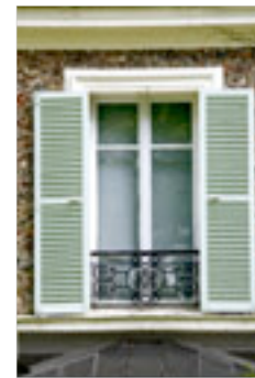
Baie à volets persiennés Encadrement mouluré, Bandeau maçonné
