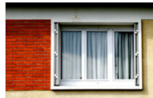
Baie à persiennes Encadrement lisse en relief, Trumeau habillé en plaquettes de brique
