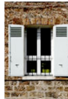
Baie à volets persiennés Linteau en brique Appui maçonné
