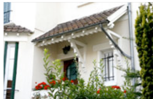
Auvents à ossature bois et couverture tuile
