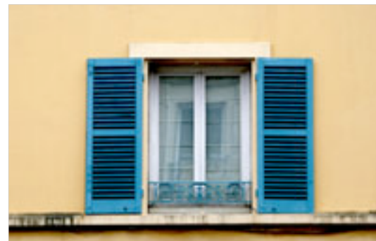
Baie à volets persiennés Encadrement lisse en saillie Bandeau
