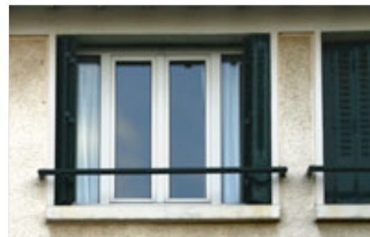
Baie à persiennes Encadrement lisse en relief Barres d'appui "tube"
