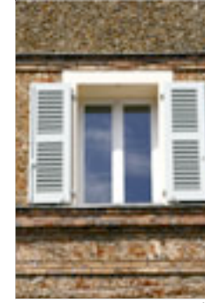
Baie à volets persiennés Encadrement lisse Bandeau en brique
